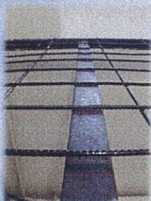
Expandált lemez felszerelése
