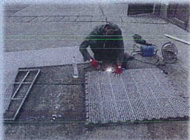
Expandált lemez felszerelése
