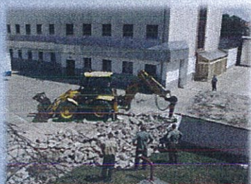
Rámpa elbontása - parkoló kialakítása
